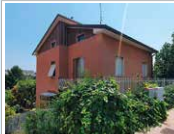
A269167A6 ZONA BARACCOLA
