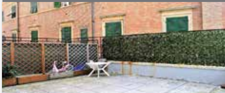
C108 P.ZZA DIAZ RISTRUTTURATO CON TERRAZZO
